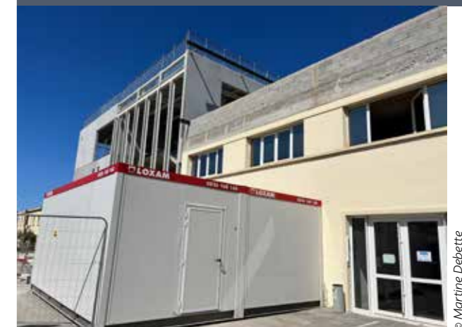
Le bâtiment en construction.
